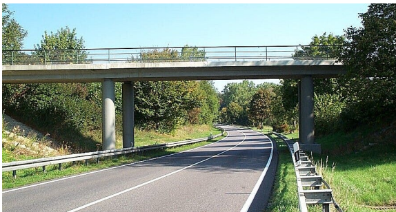
Brücke über den Gemeindeweg in Richtung Tannenbühl
