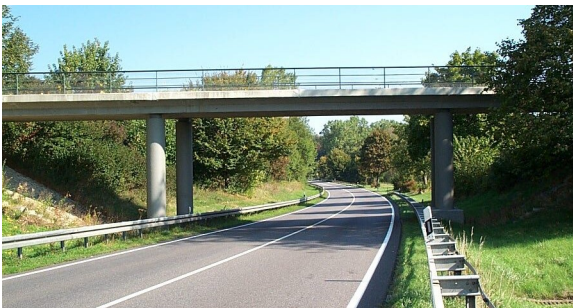
Brücke über den Gemeindeweg in Richtung Tannenbühl
