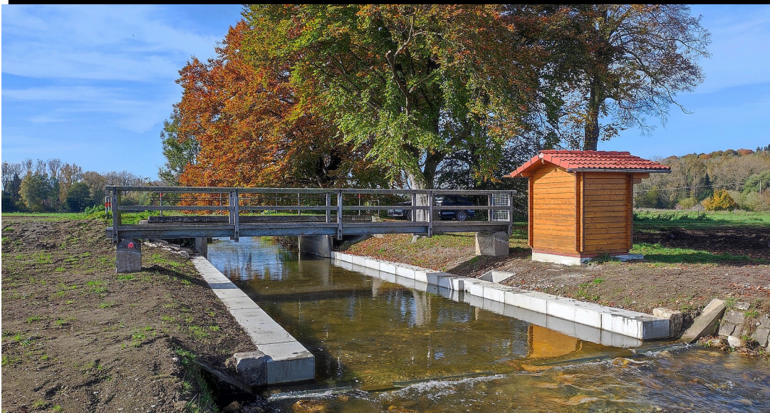
Pegelanlage Mengener Ablach
