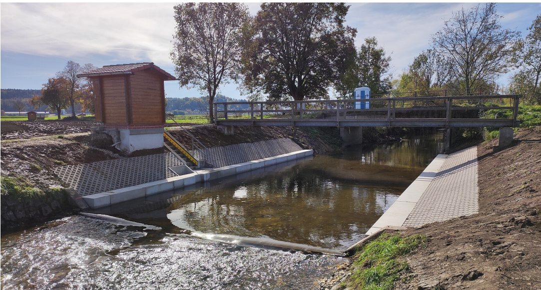
Pegelanlage Ennetacher Ablach
