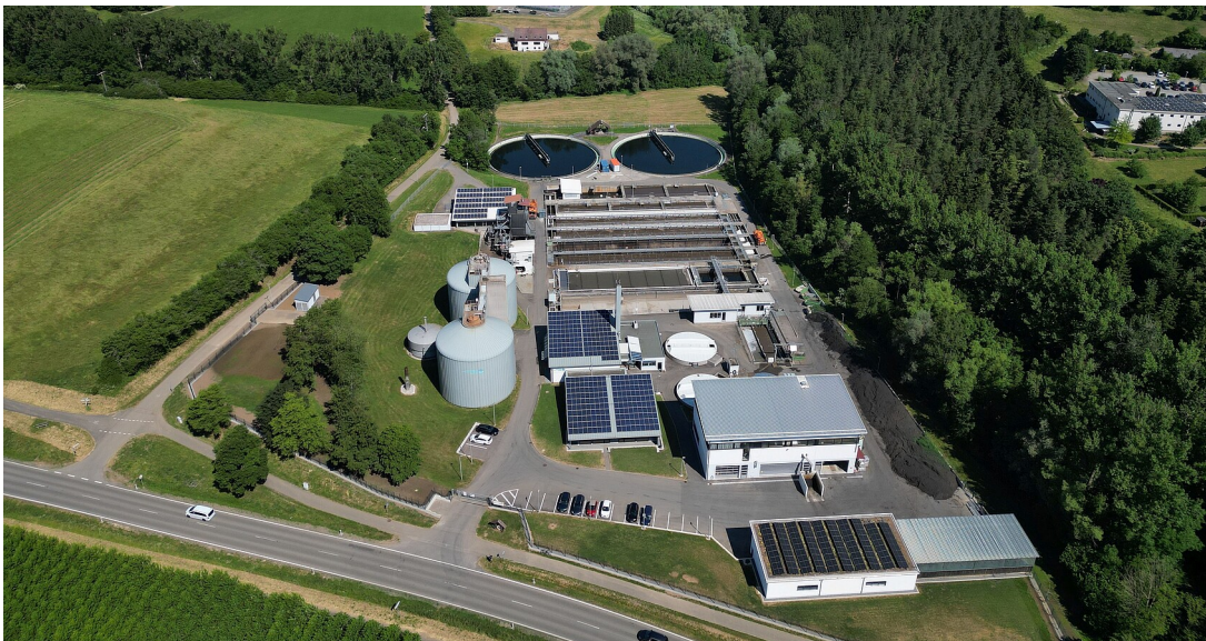
Blick von oben auf die Kläranlage Balingen
