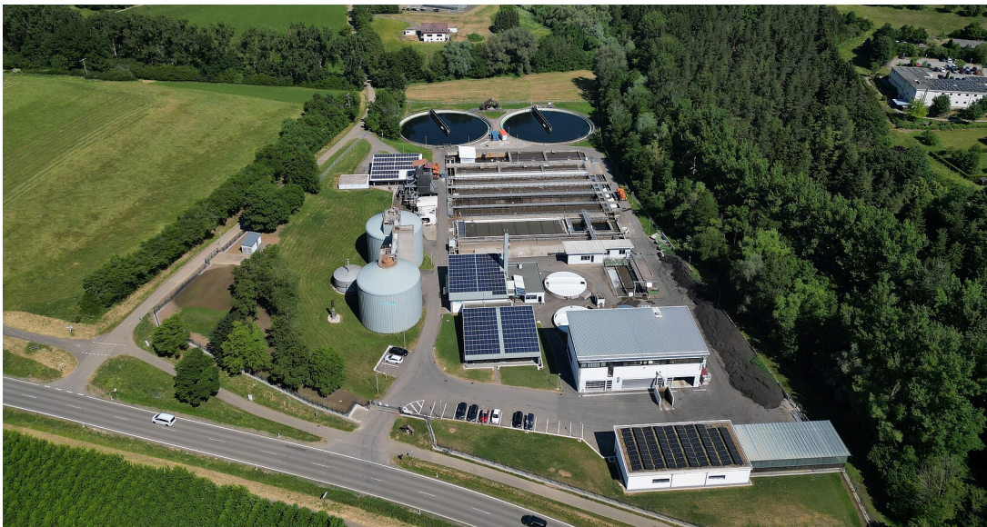
Blick von oben auf die Kläranlage Balingen
