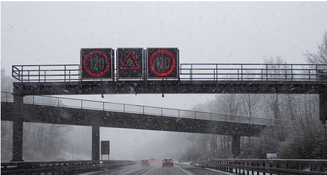
Verkehrsbeeinflussungsanlage
