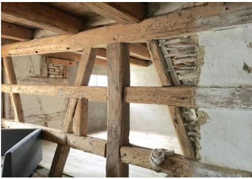
Innenansicht freigelegtes Fachwerk zum Teil wieder hergestellt und im Urzustand
