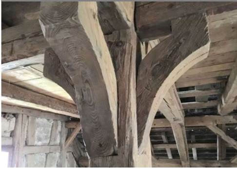
Hausdecke welche von hölzernen Balken abgestützt werden
