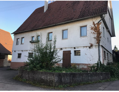
Außenansicht, 71116 Gärtringen-Rohrau, Nufringer Str. 7
