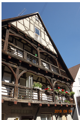
Aussenansicht, 71263 Weil der Stadt
