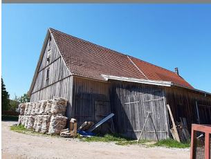
Südwestseite Oberreichenbach, Sauerstr. 5
