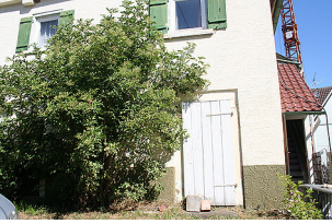
Außenansicht des Gebäudes Heubergstraße 5, Waldachtal-Salzstetten
