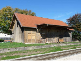
Außenansicht, 89168 Niederstotzingen, Bahnhofstr. 53
