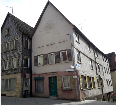
Außenansicht, 74196 Neuenstadt am Kocher, Hauptstraße 7
