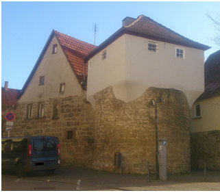
Gebäudeansicht, 74613 Öhringen, Poststraße 17 + 17/1
