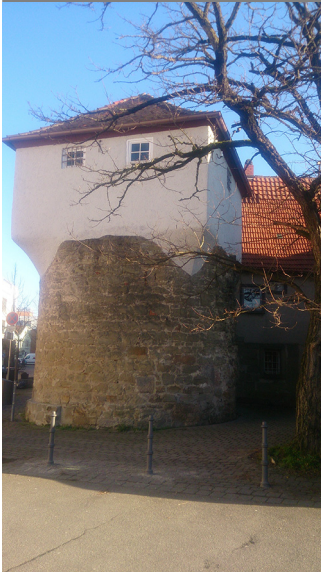
Gebäudeansicht, 74613 Öhringen, Poststraße 17 + 17/1
