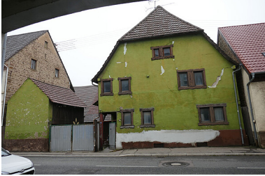
Wohnhaus Ansicht Süd Östringen-Odenheim, Eppinger Str. 41
