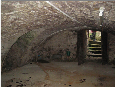
Ansicht Gewölbekeller Östringen-Odenheim, Eppinger Str. 41
