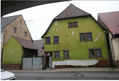
Wohnhaus Ansicht Süd Östringen-Odenheim, Eppinger Str. 41
