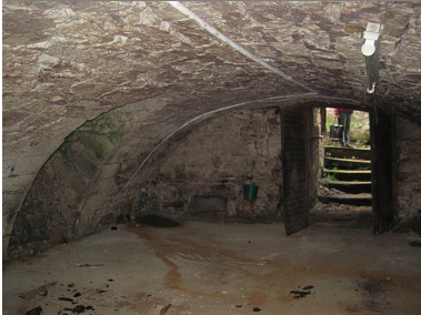
Ansicht Gewölbekeller Östringen-Odenheim, Eppinger Str. 41
