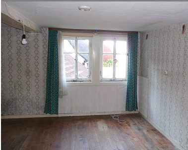
Innenansicht Objekt Osterburken-Bofsheim, Brückenstraße 44
