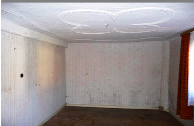
Innenansicht Objekt Osterburken-Bofsheim, Brückenstraße 44
