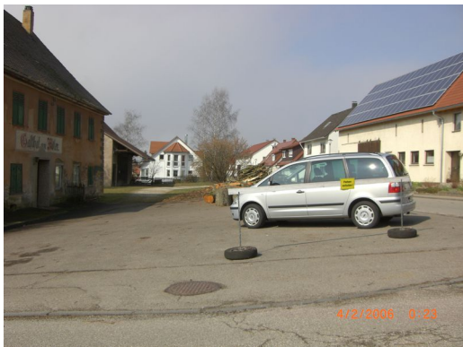
Gebäudeansicht, 73450 Neresheim (Härtsfeld), Vorstadtstraße 1
