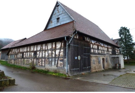
Gebäudeansicht, 71549 Auenwald-Däfern, Dorfstraße 17
