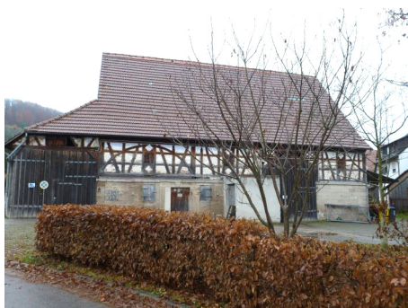
Gebäudeansicht, 71549 Auenwald-Däfern, Dorfstraße 17
