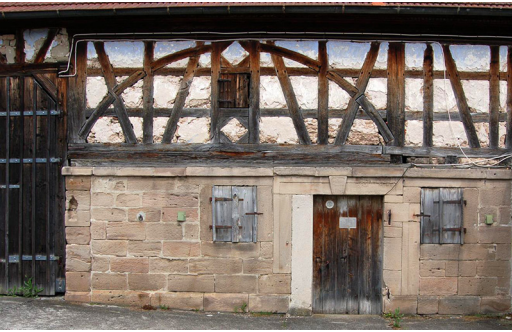
Gebäudeansicht, 71549 Auenwald-Däfern, Dorfstraße 17
