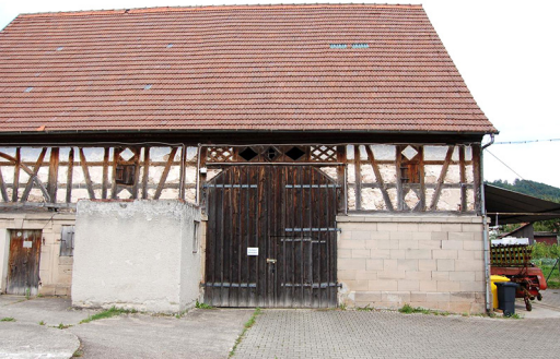
Gebäudeansicht, 71549 Auenwald-Däfern, Dorfstraße 17
