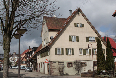
Außenansicht des Gebäudes Ortsstraße 8, Freudenstadt-Wittlensweiler
