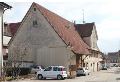
Seitenansicht des Gebäudes
