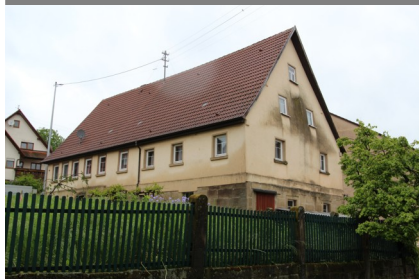
Gebäudeansicht, 74639 Zweiflingen-Orendelsall, Forchtenberger Straße 26
