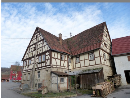
Gebäudeansicht, 74653 Künzelsau-Kocherstetten, Erlesbachgasse 4
