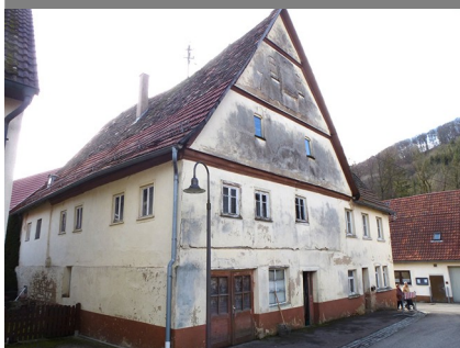
Gebäudeansicht, 74653 Künzelsau-Kocherstetten, Erlesbachgasse 4
