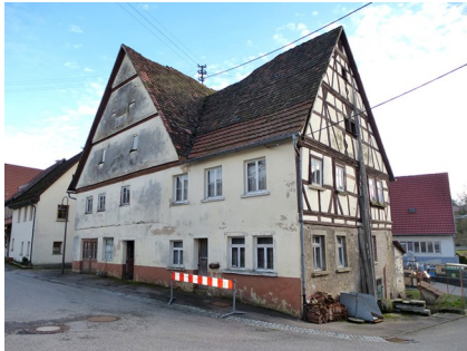
Gebäudeansicht, 74653 Künzelsau-Kocherstetten, Erlesbachgasse 4
