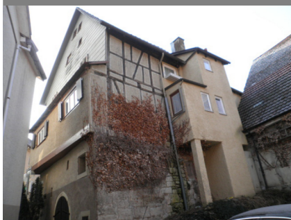
Gebäudeansicht, 74653 Künzelsau, Schlossmühlgasse 1
