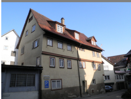
Gebäudeansicht, 74653 Künzelsau, Schlossmühlgasse 1
