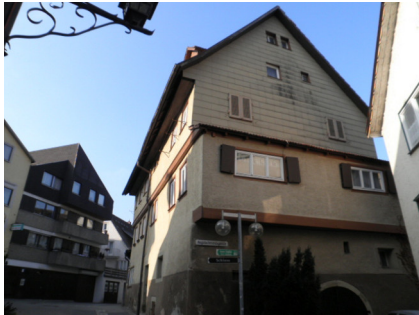
Gebäudeansicht, 74653 Künzelsau, Schlossmühlgasse 1
