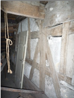
Dachboden, 74673 Ailringen, Alte Poststraße 2
