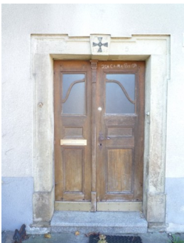
Ansicht Eingangstür, 74673 Ailringen, Alte Poststraße 2
