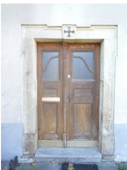
Ansicht Eingangstür, 74673 Ailringen, Alte Poststraße 2
