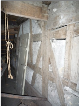
Dachboden, 74673 Ailringen, Alte Poststraße 2
