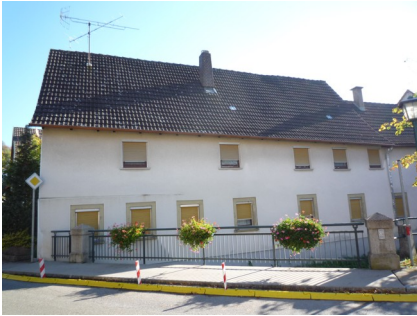
Gebäudeansicht, 74673 Ailringen, Alte Poststraße 2
