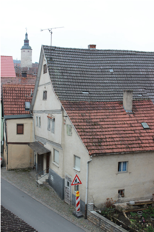
Gebäudeansicht, 97941 Tauberbischofsheim, Badgasse 14
