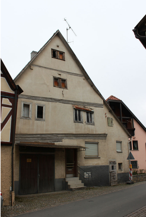
Gebäudeansicht, 97941 Tauberbischofsheim, Badgasse 14
