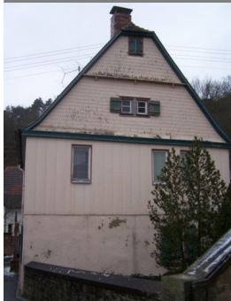
Gebäudeansicht, 97956 Werbachhausen, Klingenstraße 10
