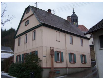
Gebäudeansicht, 97956 Werbachhausen, Klingenstraße 10
