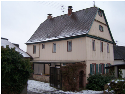
Gebäudeansicht, 97956 Werbachhausen, Klingenstraße 10
