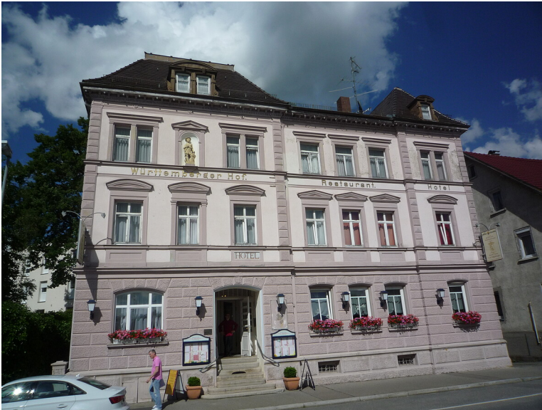
Gebäudeansicht, 88348 Bad Saulgau, Karlstraße 13
