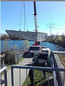
Ponton (=Schwimmplattform) Teil 1 wird in den See gehoben
