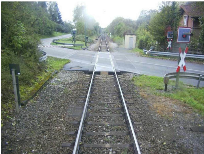
Abbildung 3: BÜ bei Bahn-km 128,2+160 (Blickrichtung Eppingen)
