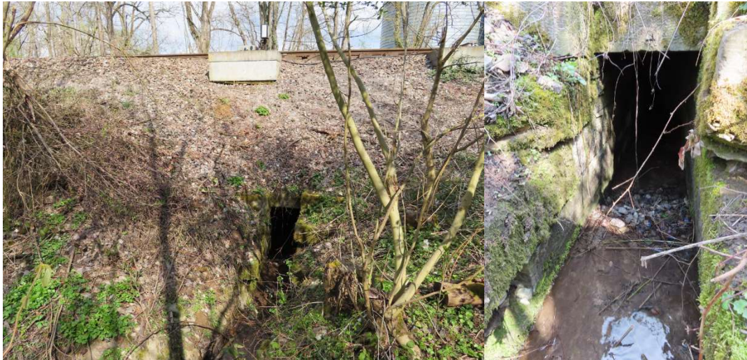
Abbildung 9: Durchlass Nr. 1 (Bilder I.d.B)
