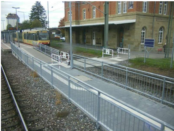
Abbildung 5: RÜ bei Bahn-km 129,8+97
