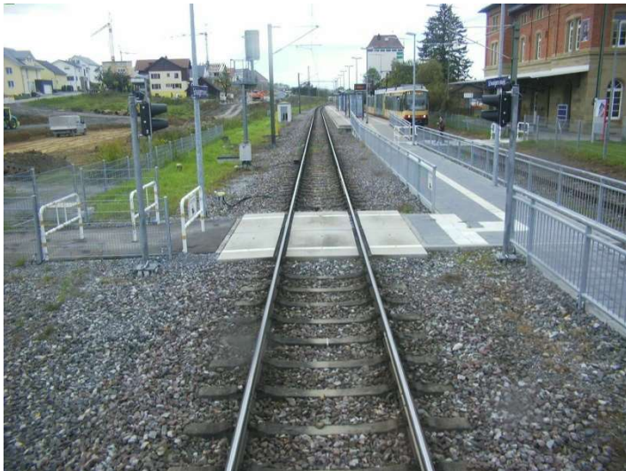
Abbildung 4: RÜ bei Bahn-km 129,8+74
