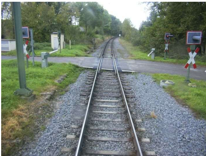
Abbildung 2: BÜ bei Bahn-km 127,3+21 (Blickrichtung Eppingen)
