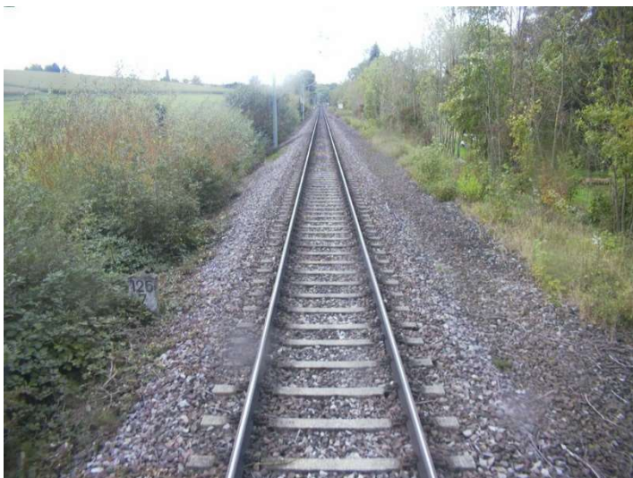
Abbildung 14: Ursprünglich zweigleisiger Abschnitt Ortsausgang Leingarten (Blickrichtung Eppingen)
