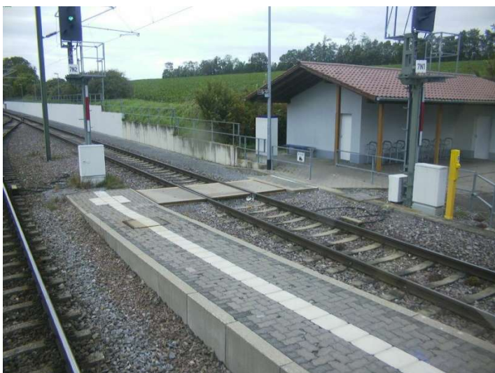
Abbildung 6: RÜ bei Bahn-km 131,0+59
