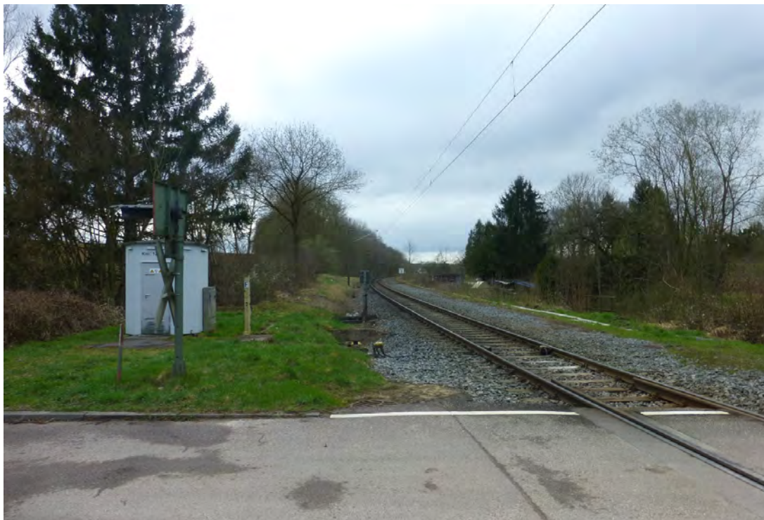
Abb. 5: Bahnübergang bei Bahn-km 127,3, Blickrichtung West.
