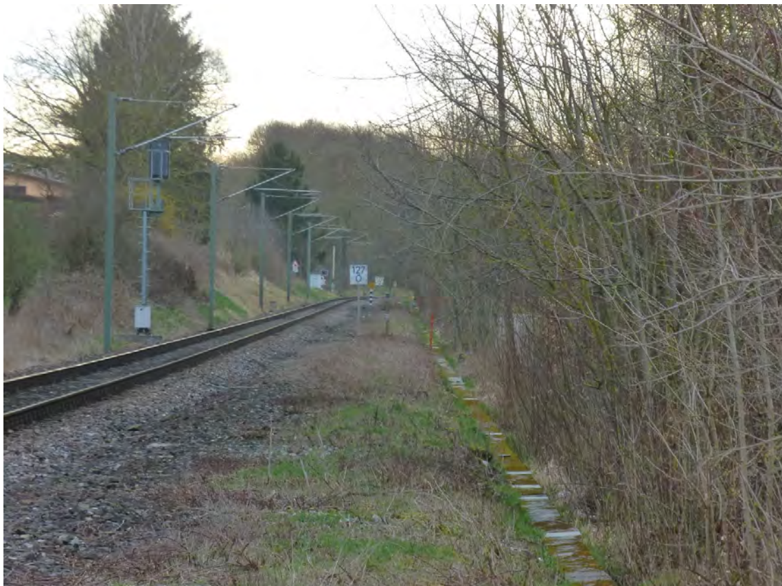
Abb. 4: vorhandener Erdkörper der ehemaligen Zweigleisigkeit.
