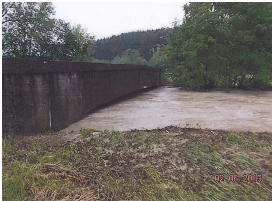
Bild 1: bordvoller Abfluss der Obern Argen an der Brücke
