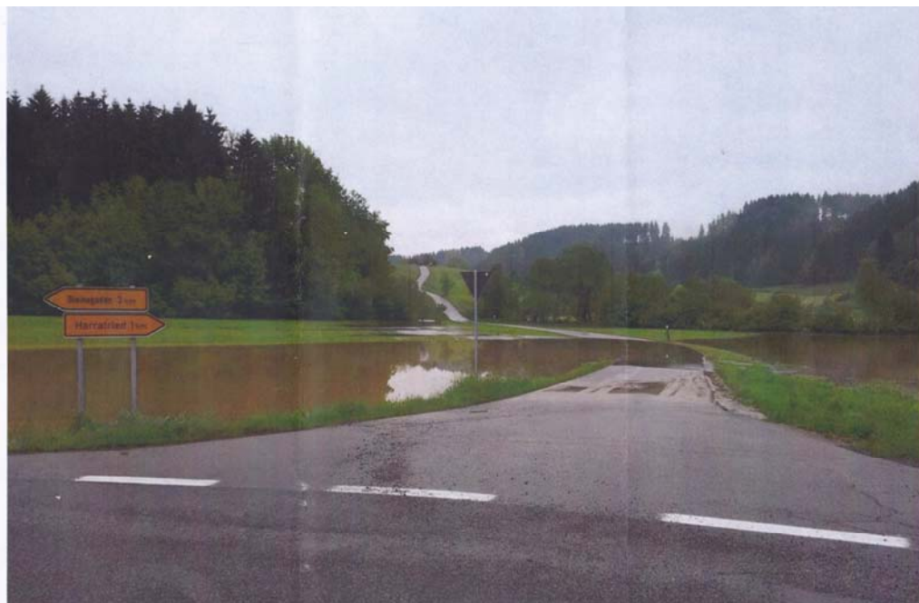
Bild 3: Überflutungen oberhalb und unterhalb der Abzweigung der Kreisstraße Li12 nach Harratsried.
