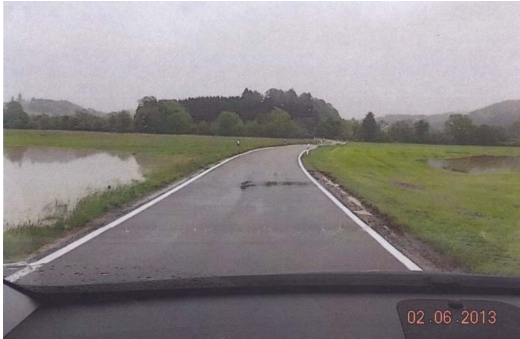
Bild 2: Überflutungen oberhalb und unterhalb der Kreisstraße K8011
