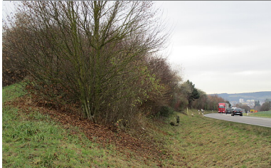
B 311 - Blick von Bau-Km 0+550 (Fußweg Alter Postweg) in Richtung Westen (stadteinwärts)
