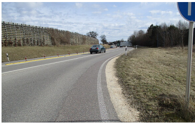
B 311 Beginn der künftigen Dreistreifigkeit im Bereich Ulmer Straße (Bauanfang)
