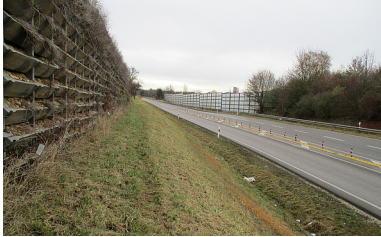
B 311 - Blick vom Bauanfang in Richtung Osten ("Borstkreuzung")
