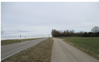
B 311 Blick von Bau-km 1+500 in Richtung Gamerschwang
