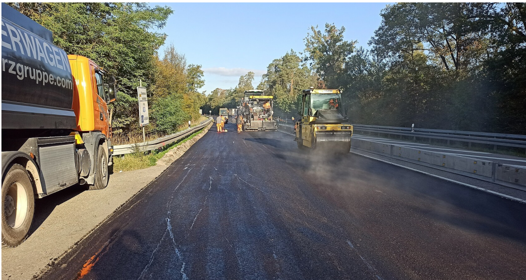
Einbau der Asphaltbinderschicht auf der südlichen Fahrbahn der B 500 (Fahrtrichtung Sinzheim)
