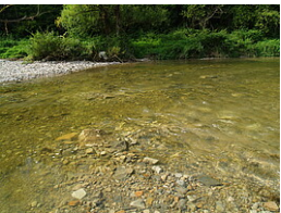
Verbesserung der Sohlstruktur durch Kieszugabe
