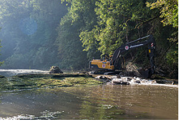
erstellung der ökologischen Durchgängigkeit durch Rückbau des Wehres an der ehemaligen Gaismühle
