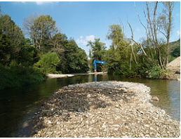
Einbau von hochwassersicheren Kiesbänken und Kiesinseln
