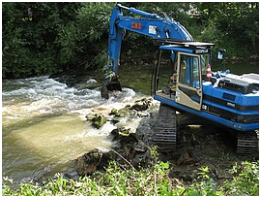
Herstellung der ökologischen Durchgängigkeit durch Rückbau der Sohlschwelle Widdern
