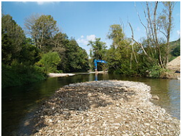
Einbau von hochwassersicheren Kiesbänken und Kiesinseln
