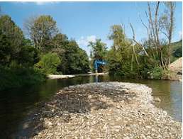
Einbau von hochwassersicheren Kiesbänken und Kiesinseln
